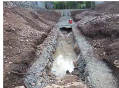
**Photos des fondations de l'impluvium et des travaux de maçonnerie**
