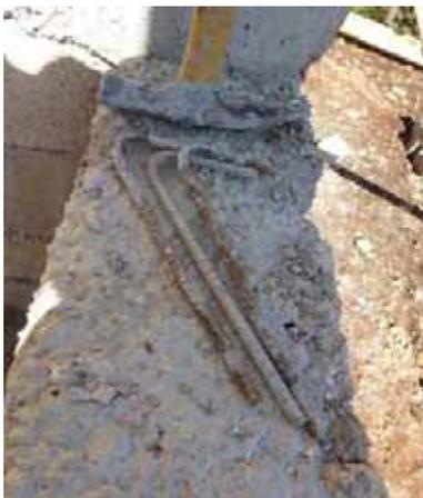
Les crochets en fer à béton doivent être prêts avant de couler la ceinture. Tendre la ficelle sur tout le bord externe de la maison et marquer à l'avance la position des crochets.
