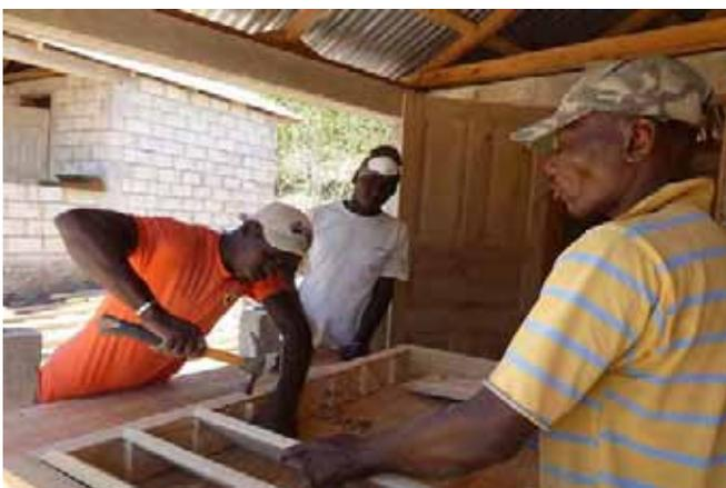
Positionnement des lames fixes avec deux clous de 6 par côté, en partant du bas.
