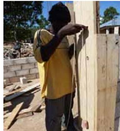
Positionnement des encadrements de porte: important de les mettre bien à plomb et de vérifier la distance = dimension de la porte.
