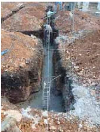
Ensuite couler le béton de propreté, à hauteur de 5 cm (à 1 cm de la ligne).
