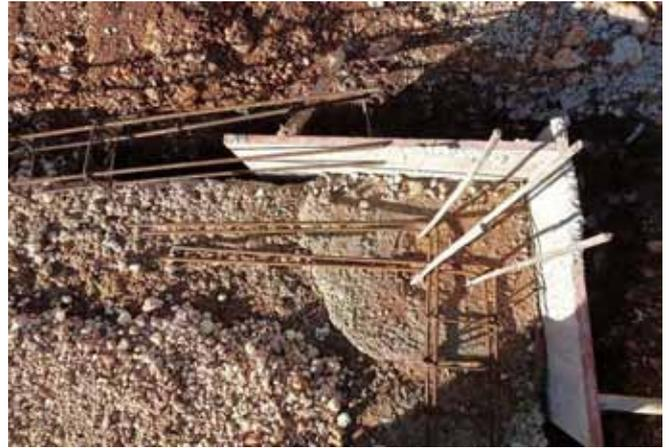
Le raccord entre les deux "poutres côté": elles se superposent de 60 cm à chaque côté du poteau.
