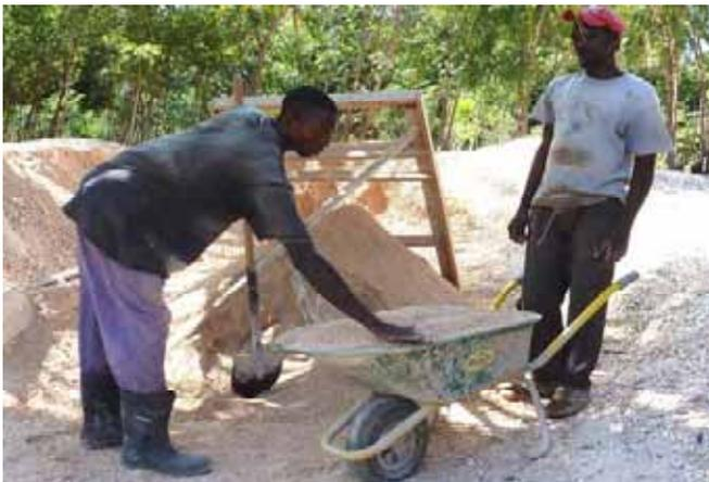
Pour la fabrication de parpaings de bonne qualité (17 parpaings/sac de ciment) on utilise 3 brouettes + 3 pelles de sable tamisé.
