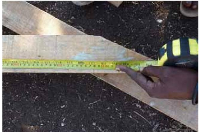
Disposer les pièces de la ferme à terre, et commencer par prendre la mesure sur l'entrait du point d'arrivé de l'arbalétrier.
