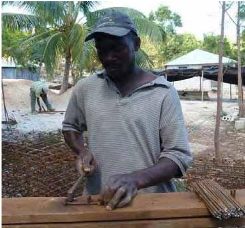
Production des épingles et des étriers avec barres de fer 6 mm, adaptés selon les plans à chaque élément.
