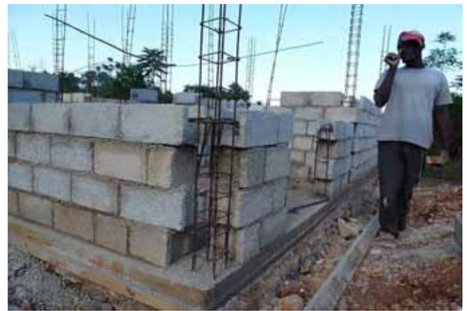
Harpage à 8/10 cm à côté des poteaux, à 5 cm ou plus pour les portes et la galerie.
