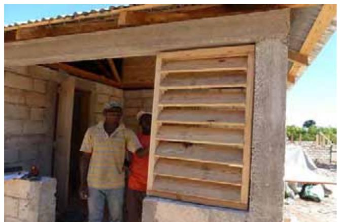
Positionnement de la persienne dans l'ossature de maçonnerie.
