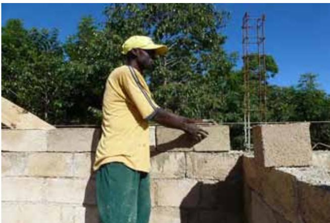
**ATTENTION** : on a presque le même résultat en terminant le rang avec deux blocs 2/3 ("3/4") ou avec un bloc normal + un 1/3 ("petit"). Utiliser les deux systèmes pour équilibrer (les blocs "3/4" et les blocs "petits" sont produits par un même moule!
