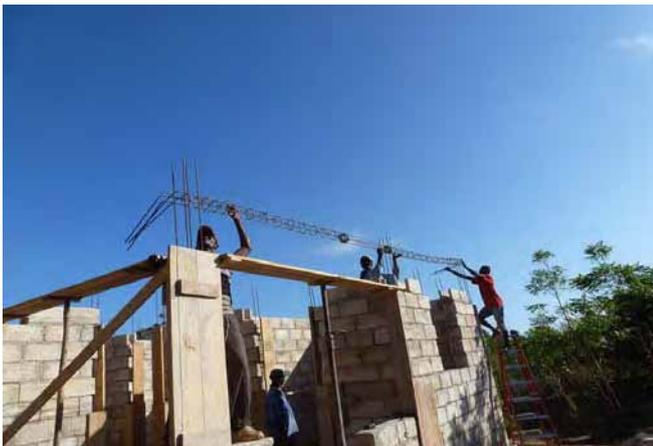
Positionner Les armatures en suivant les plans, placer les cales et ensuite replier les fers des poteaux et des "réducteurs" (chainages verticaux portes et fenêtres) dessus.
