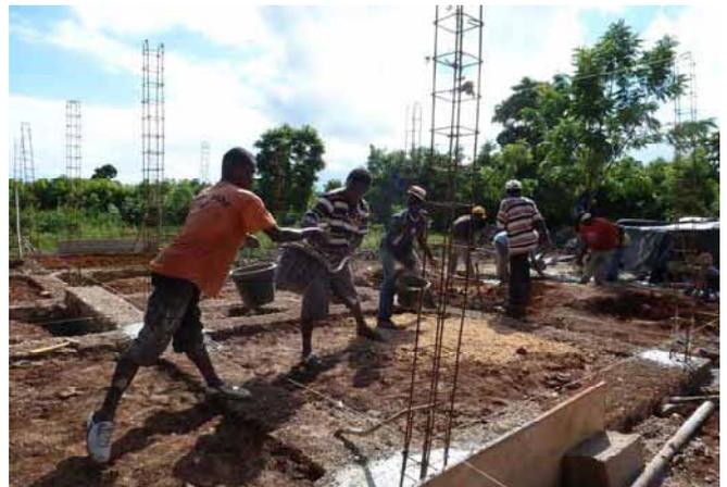
Le coulage du béton: si l'accès avec la brouette n'est pas possible, composer une ligne pour passer les "bokits".
