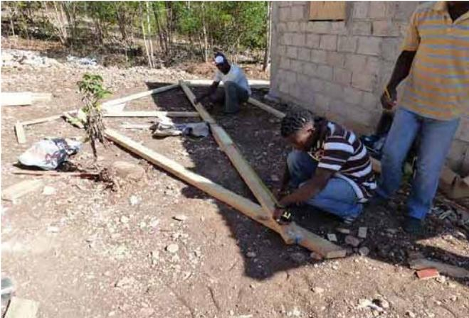
Disposer les pièces de la ferme à terre, positionner à l'aide des gabarits.
