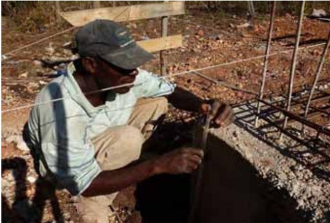
Avant de commencer le coffrage vérifier le niveau des 4 coins avec le niveau à eau.
