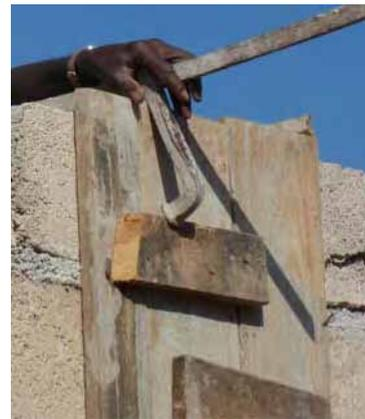
Les serre-joints servent à bloquer les coffrages en place.
