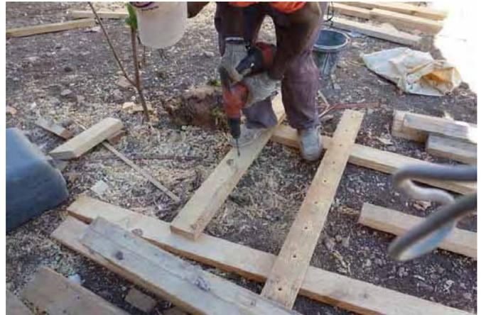
Percer les 2" x 4" pour l'insertion des barres de fer (vérifier les mesures, respecter les distances).
