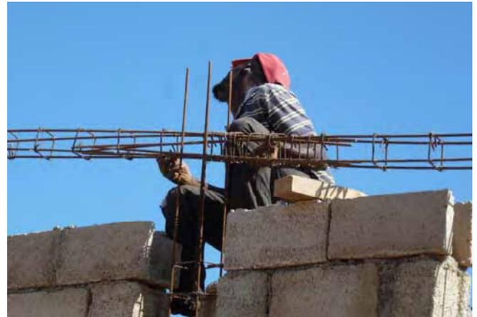
Positionnement du ferrailage au niveau de la jonction des deux poutres longitudinales (poutres "côté").
