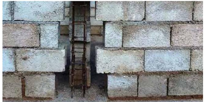
Harpage à 8/10 cm à côté des poteaux, à 5 cm ou plus pour les portes et la galerie.
