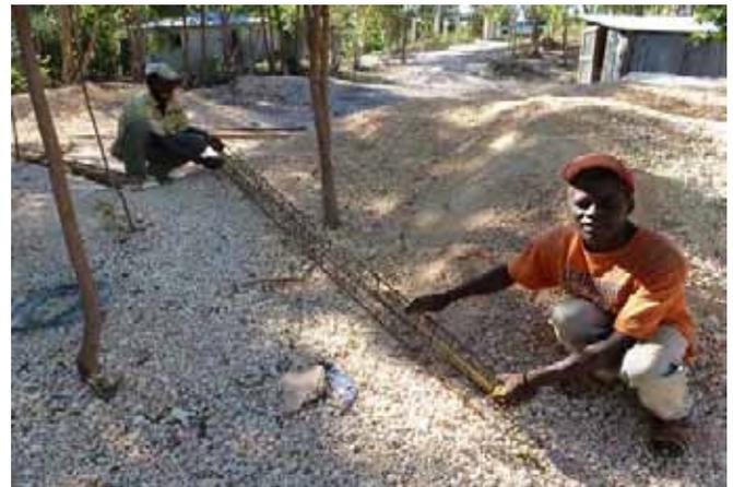
La ferraille des poteaux, avec les étriers à 10 cm sur les deux sections les plus sollicitées (60 cm au pied, 60 cm en dessous du raccord avec la ceinture supérieure).
