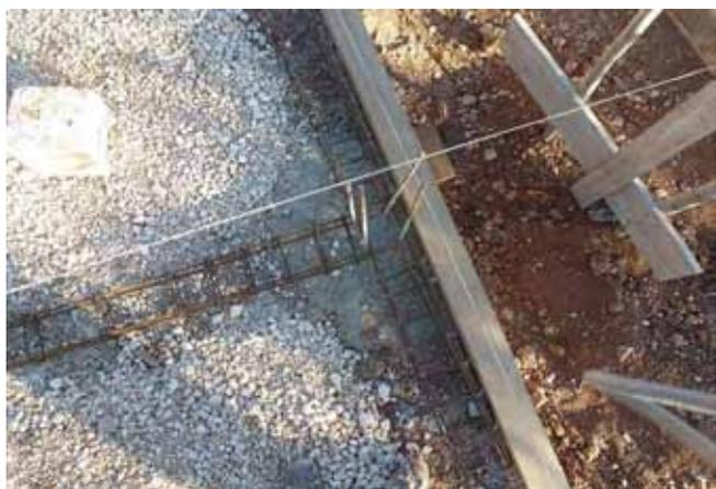
Le raccord poutre "côté" avec la poutre "milieu".
