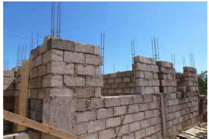
Solution d'angle avec parpaings spéciaux pour poteaux.
