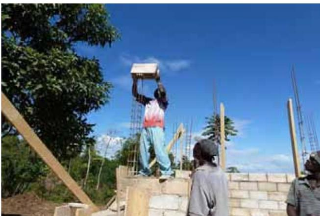
La pose des blocs "poteaux" est compliquée une fois que le ferrailage des poteaux est mis en place. Il faut préparer un échafaudage assez haut et solide.
