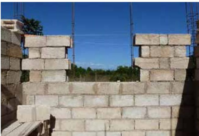
Harpage à 8/10 cm pour les poteaux, réduit à 5 cm pour les fenêtres et les portes.
