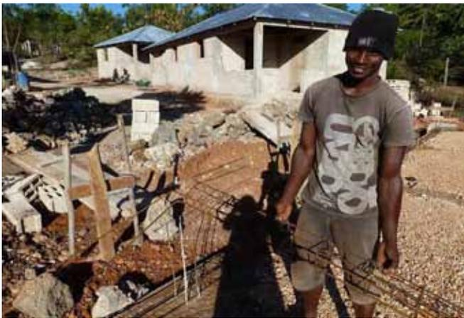
La terminaison des "poutres milieu" (transversales): crochetées des deux côtés pour être raccordée aux "poutres côté".
