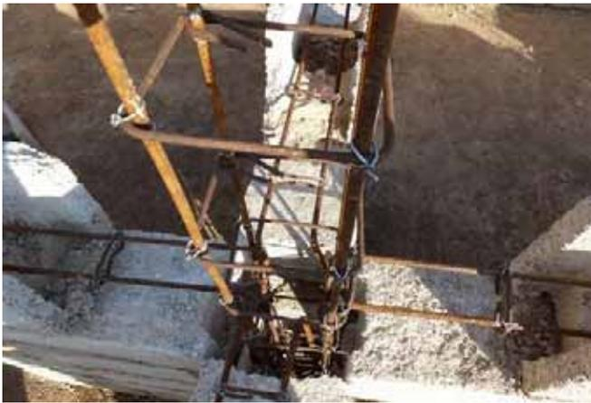
Le poteau central, avec la liaison des différentes armatures de la ceinture déjà en place.
