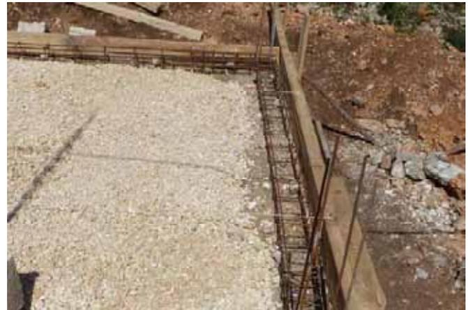
Le dernier remblayage se fait avec le gravier (10 à 15 cm). Monter 5 cm plus haut que le mur (la ceinture est de 15, mais la chape est de 10 seulement).
