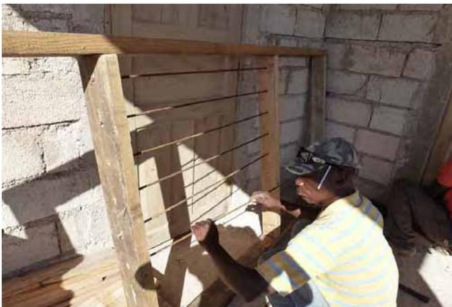
Les supports fixés au cadre, positionner les barres de fer (fer à béton, essayer d'utiliser les chutes).
