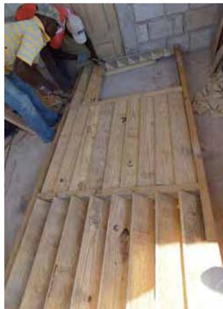
Visser la barre aux planches, en laissant dépasser le gond pour permettre une bonne ouverture. Ensuite positionner les planches fixes dans les deux cadres latéraux.
