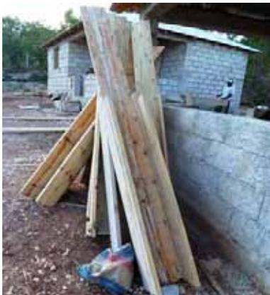
Les encadrements de porte, prêts pour le coffrage jusqu'à mi-hauteur. Ils sont pré-cloués à l'intérieur, et on décoffre que les côtés.
