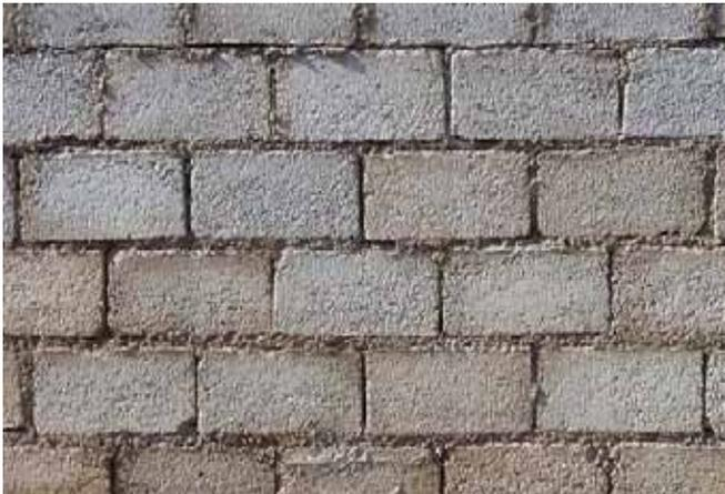
Un bon travail de maçonnerie se voit aussi dans la régularité du mur: des joints de même largeur et bien alignés (le joint tombe à la moitié du parpaing en dessous).
