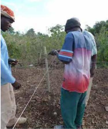
Avec le fil à plomb, marquer sur le sol les axes (dans notre maison, les points où les deux ficelles se croisent est le centre d'un poteau).
