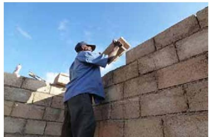
Le sixième et dernier rang est réalisé en posant les blocs "U" pour accueillir la ferraille et le béton de la dernière ceinture.
