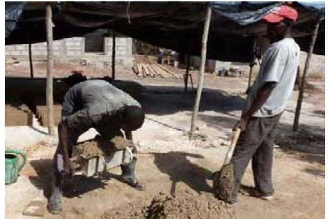
On le vibre vigoureusement en soulevant le moule et en le laissant retomber sur la plateforme.
