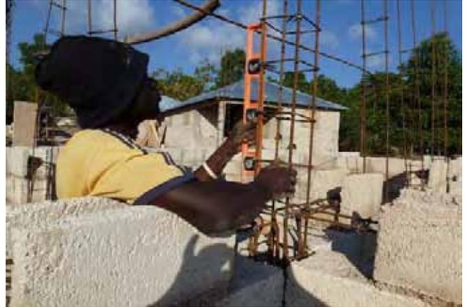
Mise à l'aplomb du ferrailage des poteaux, à corriger et revérifier pour chaque armature de ceinture fixée!
