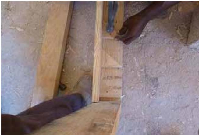
Blocage des équerres de position: la première à 10, vérifier la hauteur et distribuer les autres à 15 cm. (ajuster de quelques mm si nécessaire)
