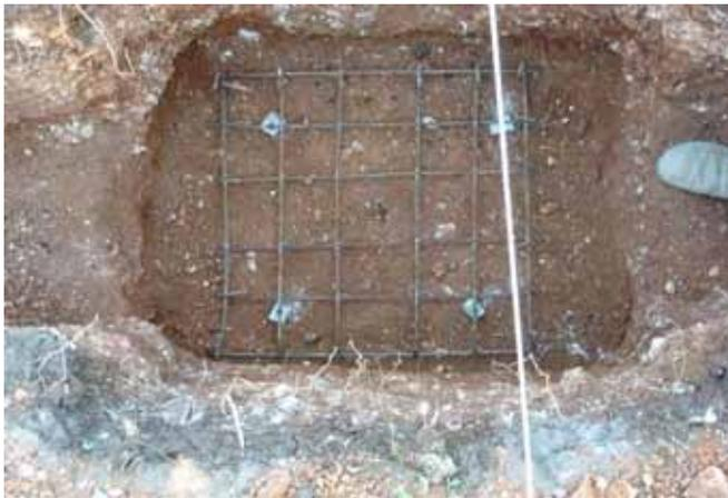
Positionnement du cadre sur cales, bien à niveau, au centre et bien droit (aligné avec les axes)
