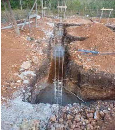
Couler le béton des semelles en premier, à hauteur de 25 cm (tirer une ligne à niveau à 26 cm).
