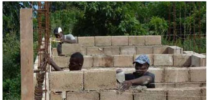
Les boss maçons au travail de pose des parpaings. Pour les murs externes, fixer la ficelle sur les lattes de niveau. Pour tous les autres, placer les premiers blocs à niveau, puis tirer la ficelle.
