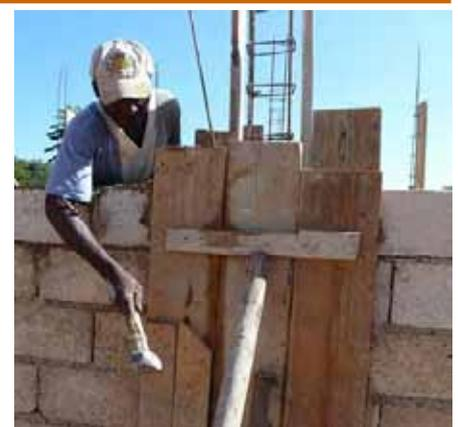
Dosage du béton pour poteaux et ceinture: 5 brouettes sable tamisé + 5 brouettes gravier lavé + 4 sacs ciment.
