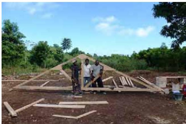
Quand toutes les flasques et la deuxième pièce d'entrait sont en position, la ferme est complète. Rajouter vis et boulons avant de la monter!
