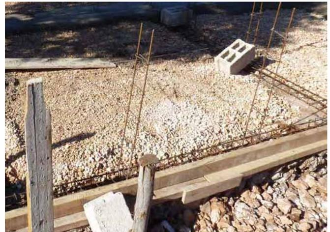
Fixation des "réducteurs" (chainages verticaux) pour les portes et la galerie.
