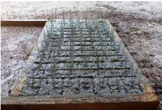
Production des cales pour béton (3x3x3 cm). Le mortier est composé d'agrégats de petite taille et est riche en ciment. Le fil de fer permettra un accrochage stable aux fers des armatures avant le coulage du béton. Les cales doivent être conservées au frais et arrosées pendant les premiers jours.
