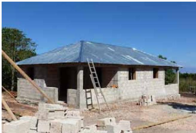
Des arêtiers en tôle complètent la toiture en assurant son imperméabilité.
