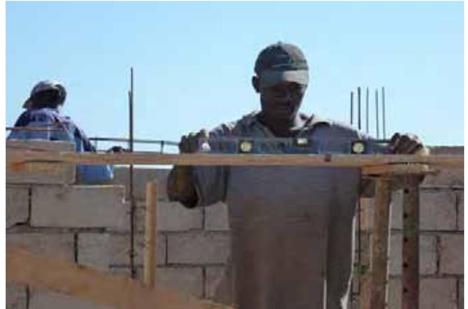
Coffrage des poteaux d'angle et les poutres : faire très attention à l'aplomb vertical et au niveau horizontal.
