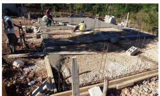
Vibrer le béton et mise à niveau avec un bois 2" x 4" (bien droit!).
