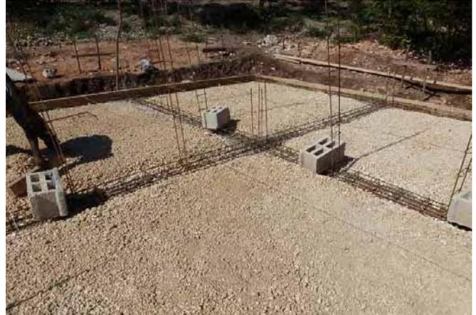
Coffrage à niveau et ferraille en place, on peut commencer à préparer le béton pour la ceinture.
