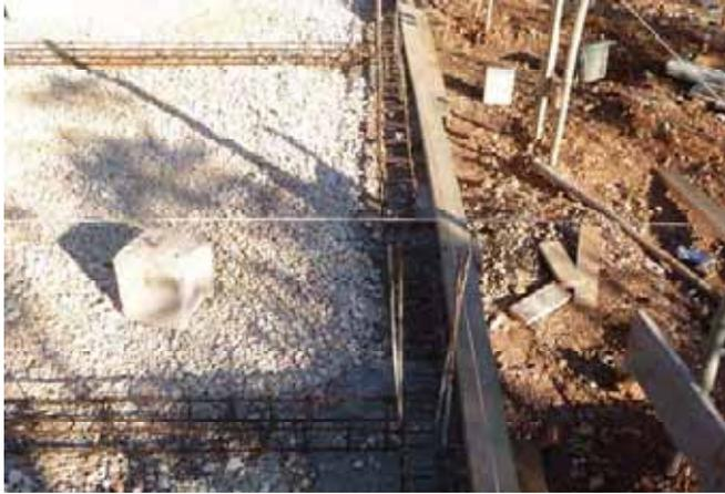
Connexion du ferrailage de la poutre externe ("côté") et des deux poutres transversales ("milieu")
