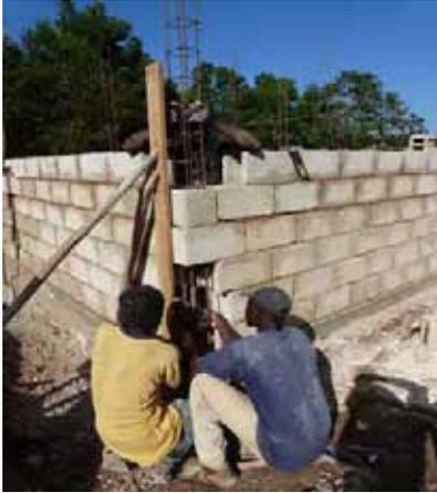
On positionne les poteaux en premier: positionnement du poteau d'angle.
