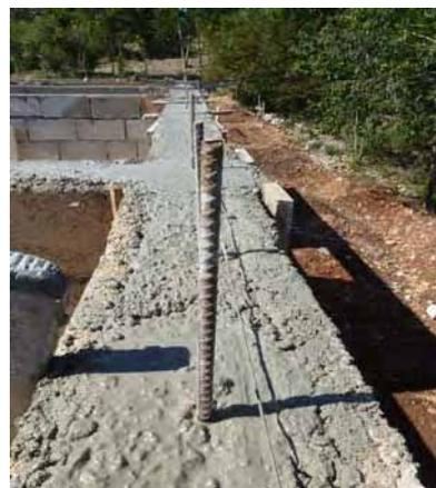
Les crochets (bien alignés) sont noyés dans le chaînage en "U".
