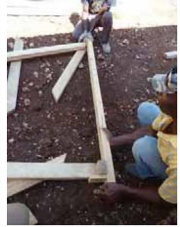
Vérifier les angles, soit avec mètre et équerre, soit avec la "pièce spéciale" d'assemblage.
