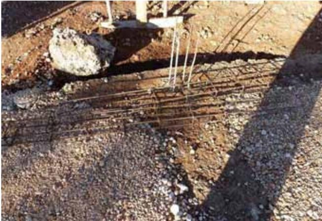
Aux 4 angles du bâtiment, la connexion entre la "poutre d'angle" et la "poutre côté": le raccord des deux barres est déjà inclus dans la poutre d'angle. Après avoir fixé toutes les armatures, on rajoute les barres de raccord à 90°.
