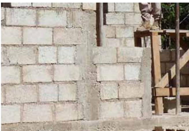
Le béton d'un poteau et à l'entrée de la galerie après décoffrage.
