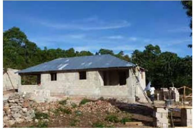
Les feuilles de tôle ondulée sont clouées sur les lattes: à chaque extrémité et au milieu.
